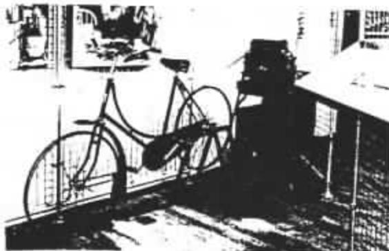
Fahrrad treibt eine Druckmaschine
