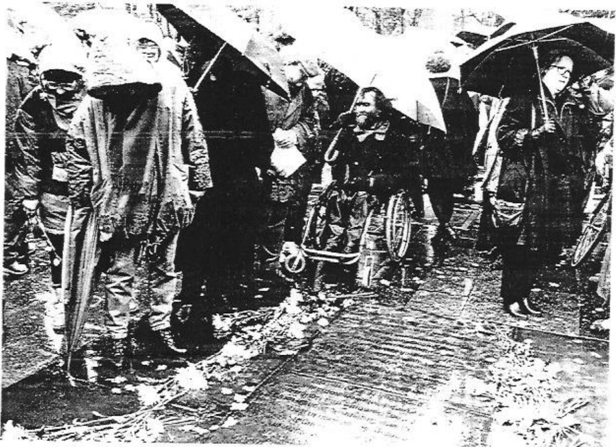
Tiergartenstraße 4 am 14. November 1993
