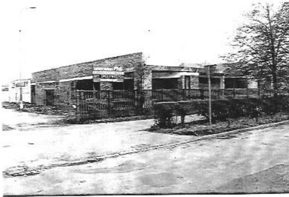
Stein(e) des Anstoßes - der Supermarkt im Rohbau.
