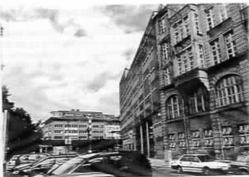
Die nördliche Burgstraße am 15.8.1999: Der Neubau des Bundesverbandes deutscher Banken (rechte Bildhälfte), dem sich der Altbau Burgstraße 27 (rechter Bildrand) anschließt. Foto: Goebel
