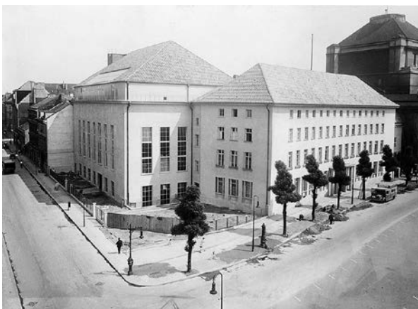
Das neugebaute Werkstatt- und Verwaltungsgebäude des Deutschen Opernhauses an der Ecke Maikowskistraße/Richard-Wagner-Straße, noch ohne die Gedenk- und Brunnenanlage, 1936
