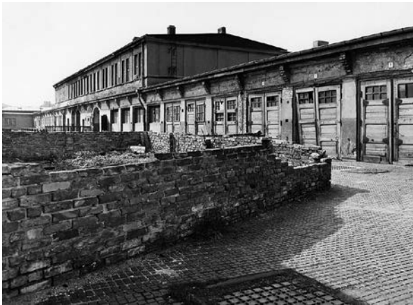
Blick auf einige der Garagen in der Seesener Straße im Mai 1964. Noch im selben Jahr wurde der Gebäudekomplex abgerissen.
